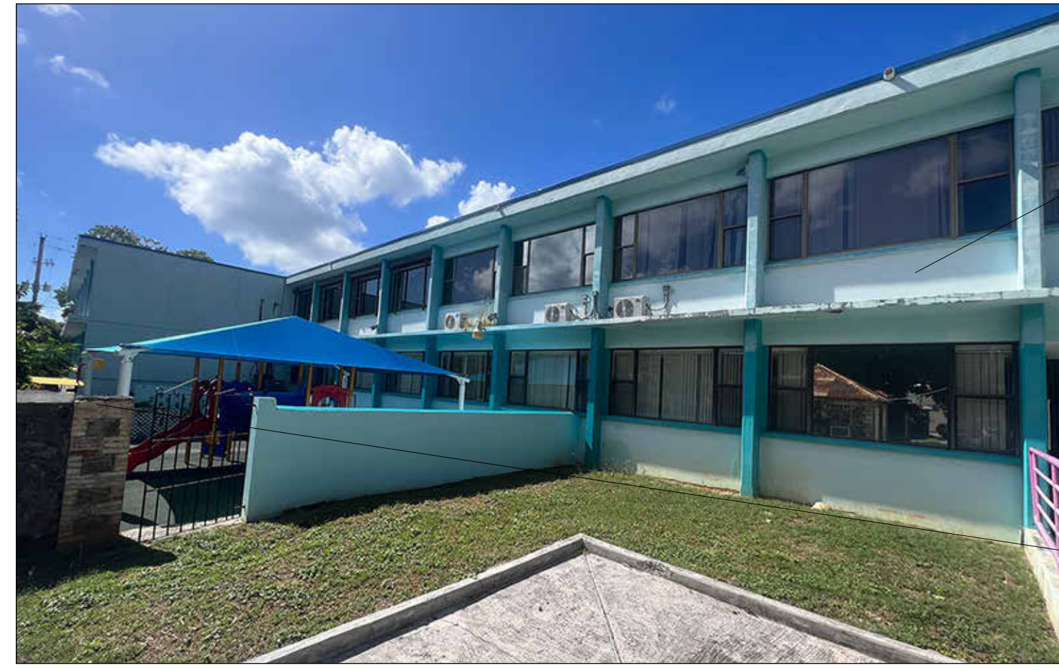
DHS KNUD HANSEN BUILDING - EAST FACADE (D)
